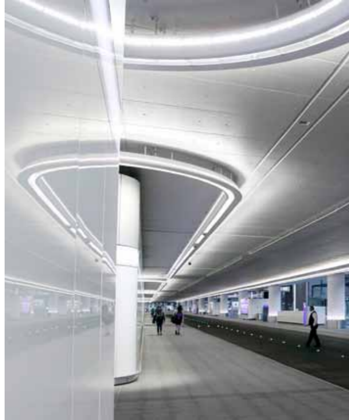
Abb.: Über das Ankunftsareal verteilen sich 22 Säulen. In der Sockelverkleidung sind Uplights von LMT mit RGB-LEDs integriert. (Foto: Fraport AG)
